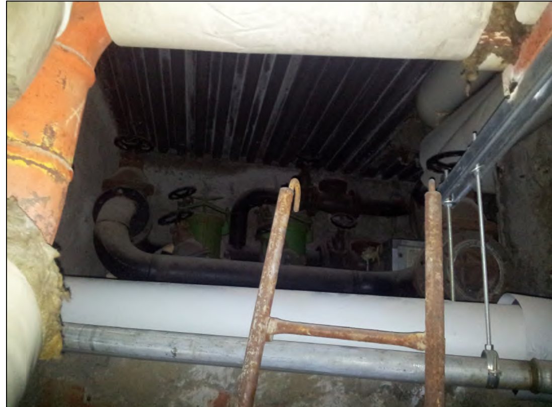
FOTOGRAFIA N. 5 DESCR.: Passaggio in cavedio delle tubazioni esistenti
