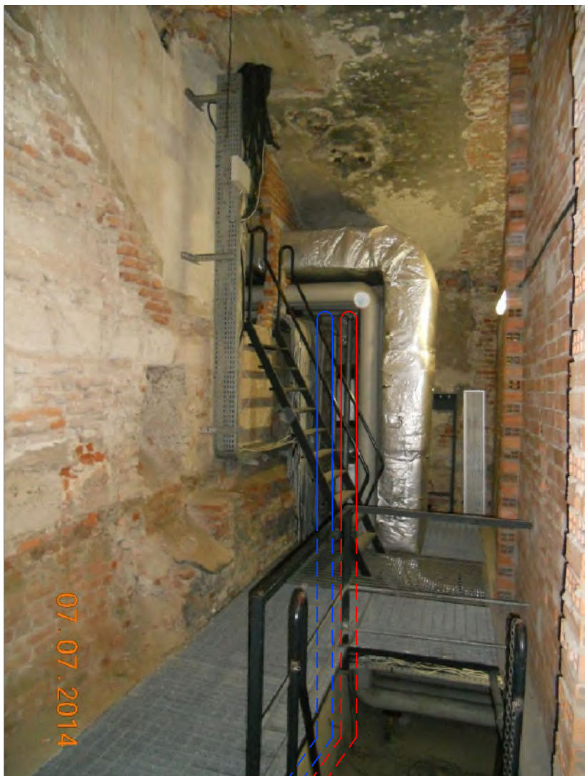
DESCR.: Ingresso tubi, discesa e posa a pav. sotto il grigliato FOTOGRAFIA N. 10
